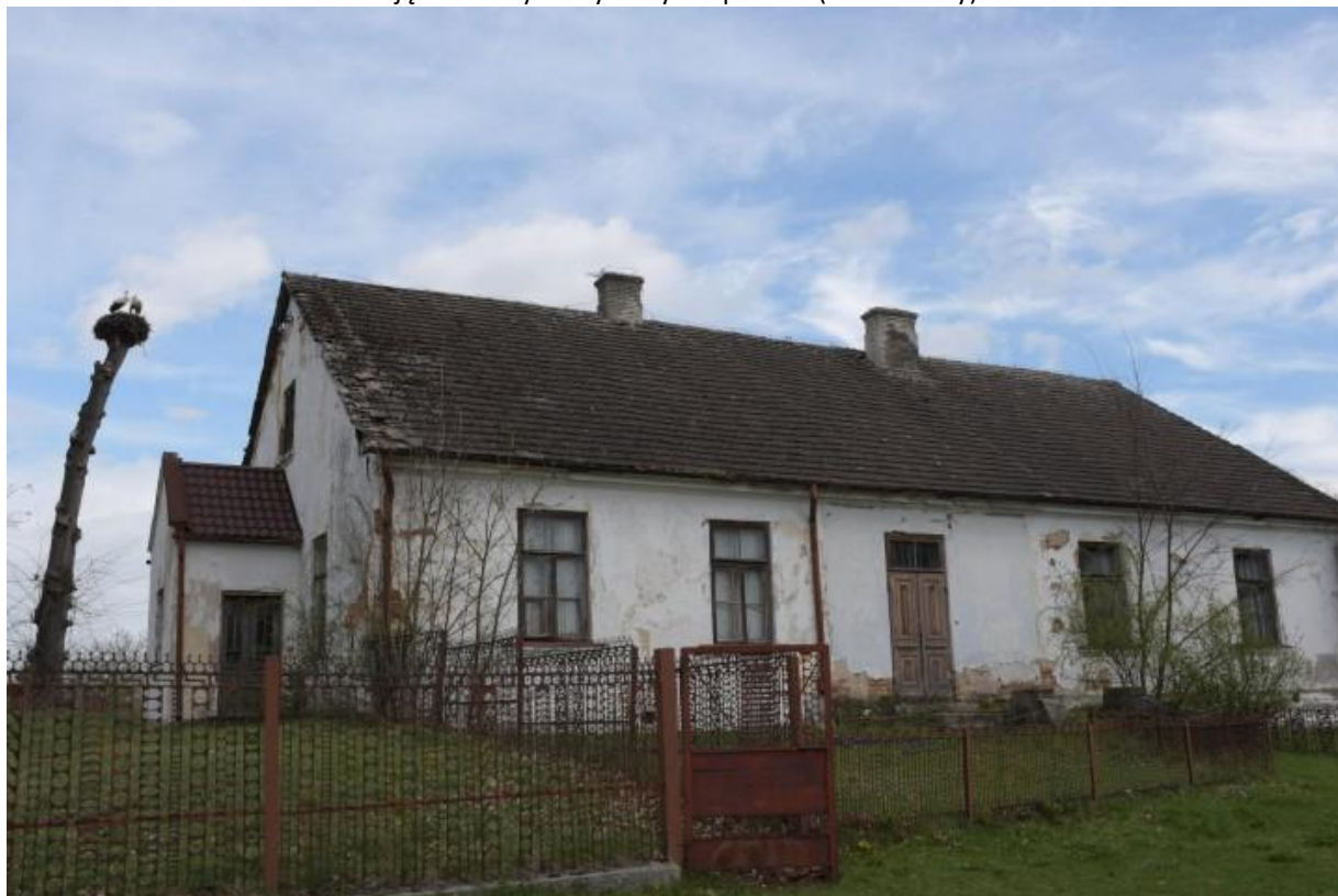
Zdjęcie 7 Zabytkowy budynek plebani (stan obecny)
